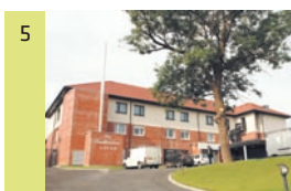
5 Quiévrechain Résidence les Feuillantines Etablissement d'Hébergement pour personnes âgées dépendantes (EHPAD) de 85 chambres dont 11 en unité de vie Alzheimer
